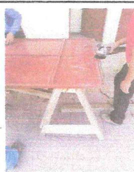
Foto 2: Sustitución de chapa y mejoramiento de puerta.
